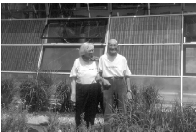
Es geht auch ohne Betonsockel unter den Modulen: Anneliese Gertsch (73) und Paul Hofer (74) freuen sich an fassadenintegrierten Solarmodulen, welche jährlich 50'000 kWh Solarstrom produzieren.
