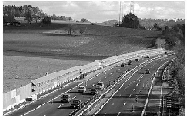
Fertig montierte Anlage (Montage nur 3,5 Tage), R. Hottinger
