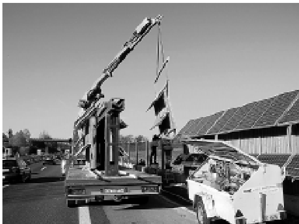
Montage der 4m breiten Schallschutzwände inklusive fertig vormontierten PV-Modulen, Bild: R. Hottinger
