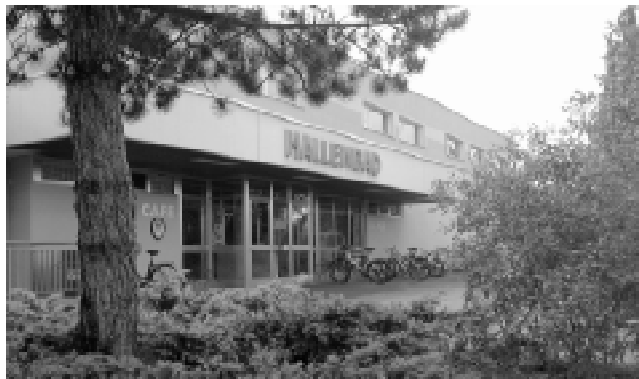
Hallenbad Seon: Der Wärmebedarf wird durch die benachbarte Trinkwasserfassung gewährleistet. Bild Alan C. Hawkins
