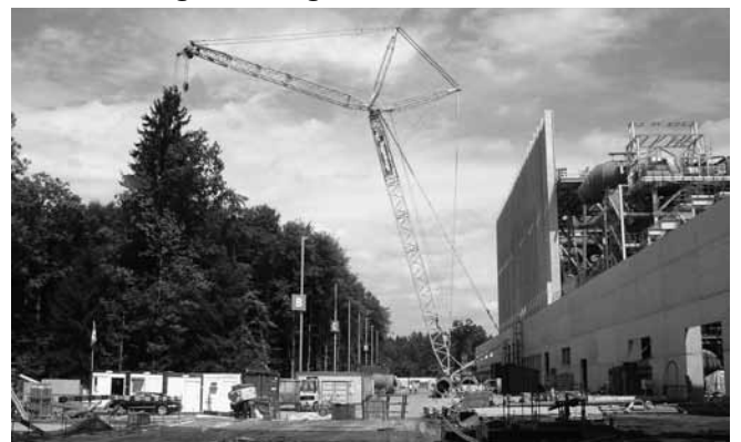
Ein Monsterkran für eine riesige Baustelle
