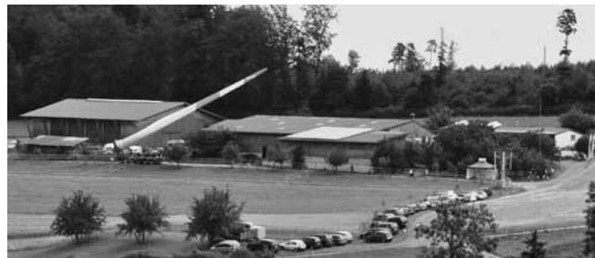
Auf dem Erushof wurde ein Spezialtransporter für Windkraftanlagen („Rotoradapter“) gezeigt. Auf dem Scheuendach ist die PV-Anlage und auf dem Wohnhausdach sind die Kollektoren zur Wassererwärmung montiert.
