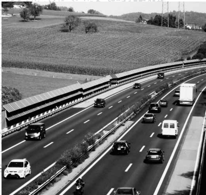
10 Jahre Photovoltaikanlage Alpha 1 in Safenwil
