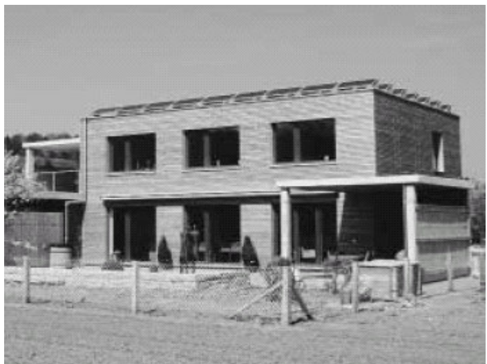
In alto vedete la prima casa Minergie costruita in Svizzera, è stata costruita in legno a Dintikon AG. Questa casa utilizza solo energie rinnovabili. (Foto Setz/LIGNUM)
